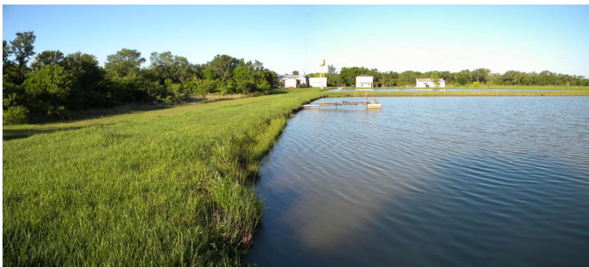
Foto 3: Estanques excavados en tierra en el CENADAC
